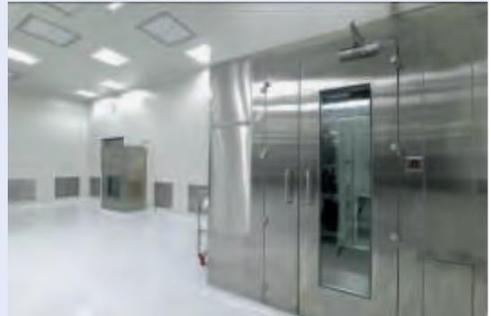
Revestimiento de AIRE - Compartimiento que evita la entrada de impurezas en la fabricación de las películas.
